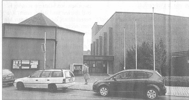
Das Gebälk der Bonifatius-Kirche (r.) ist wieder in Ordnung, jetzt wird das undichte Dach gemacht, links das Oktogon. Foto: Archiv
